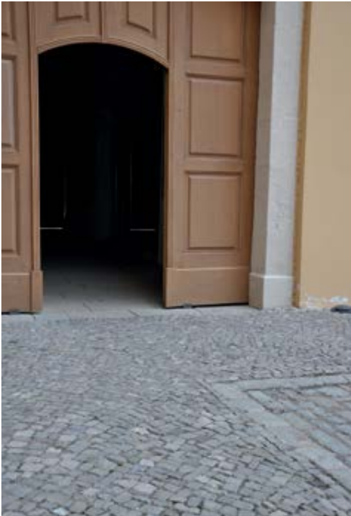
Schloss Ettersburg, Verbindung historischer und rollstuhlgerechter Pflasterung im Hof.
